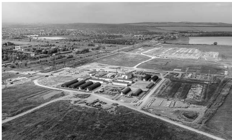
Рис. 1. Строительство цехов сварки и окраски в Усть-Каменогорске
